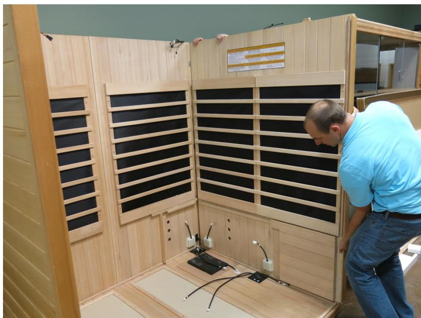
*Remarque : Lorsque les parois sont correctement mises en position, les dessus des coins doivent être à ras. Si un des panneaux est plus élevée que l'autre, le panneau n'a pas mis correctement ou alors il y a quelque chose sous le panneau.*
