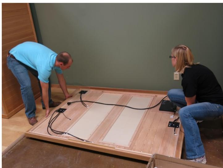
**Remarque – NE BRANCHEZ PAS ENCORE le câble d'alimentation de la cabine dans la prise de courant (230 V c.a. / 10 A).**
