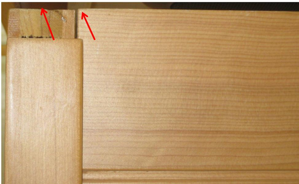
**Remarque :** Lorsque les panneaux sont correctement installés, les dessus des coins sont plans et à ras.
