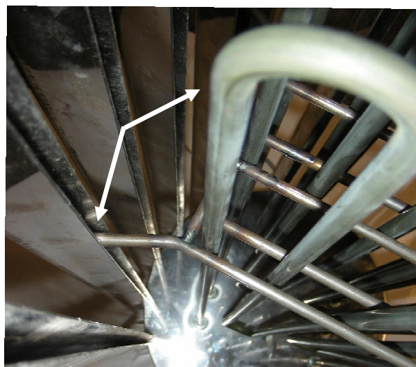
Immagine 3 Installazione del supporto per gli elementi riscaldanti
